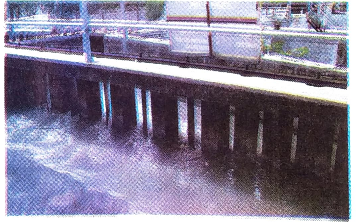
চিত্র ১৮.৪ মিহি শিলগুটি আৰু বালি আঁতৰোৱা চৌবাচ্চা
